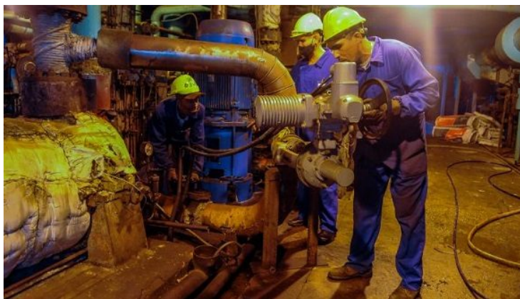
Underhållsarbete på kraftverket "Otto Parellada". Foto: ACN
