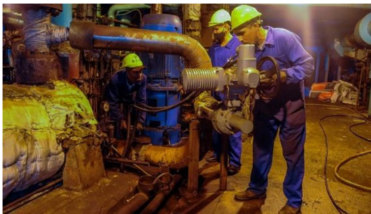
Underhållsarbete på kraftverket "Otto Parellada". Foto: ACN
